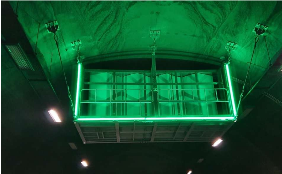
미세먼지 저감시설 구축공사
