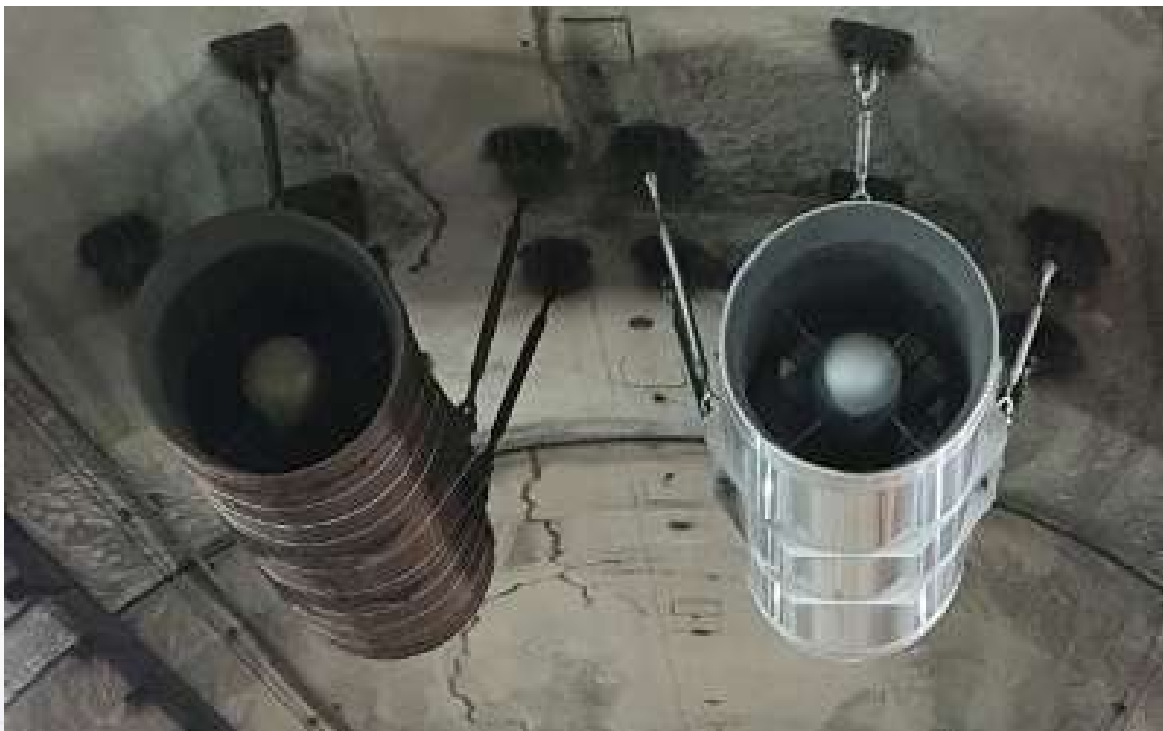
JET FAN 교체 후
